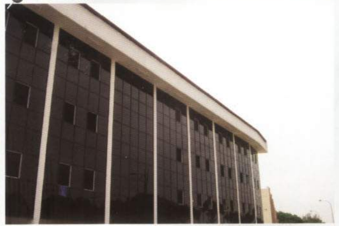
工程接近竣工
