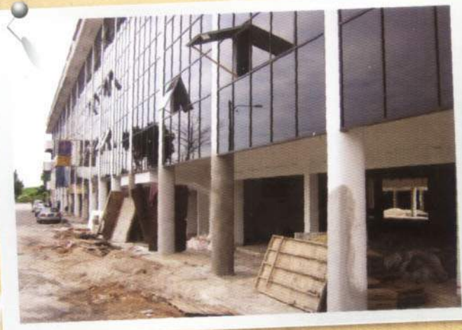
玻璃安装工程完成
